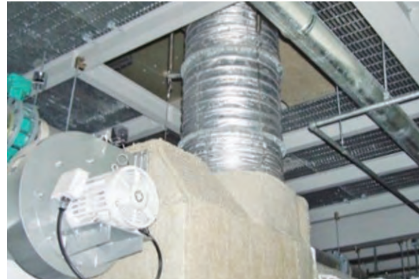
ボイラ燃焼ガス用 耐熱280℃仕様 免震量500 口径φ600×取付長1350L (本体はガラスクロス等の複合材)
