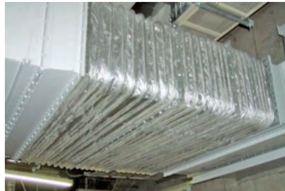
排煙用 耐熱280℃仕様 免震量500 口径1980/580□×取付長1600L (本体はガラスクロス等の複合材)
