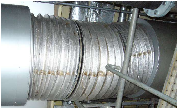
非常時の自家発電排ガス用 耐熱500℃仕様 免震量500 口径φ500×取付長1350L (本体はガラスクロス複合材)
