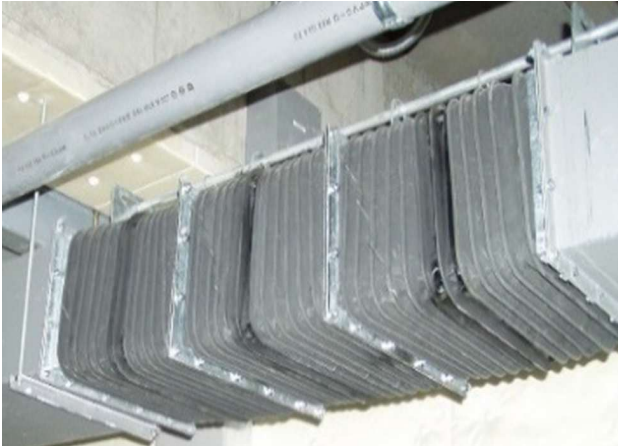
空調用 常温仕様 免震量500 口径400/250□×取付長1350L (本体はクロロプレンゴム製)
