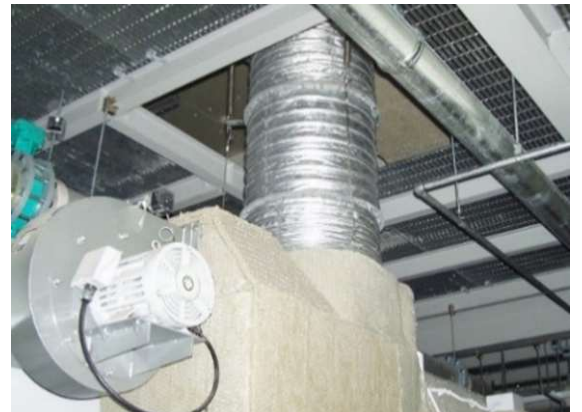
ボイラ燃焼ガス用 耐熱280℃仕様 免震量500 口径φ600×取付長1350L (本体はガラスクロス等の複合材)
