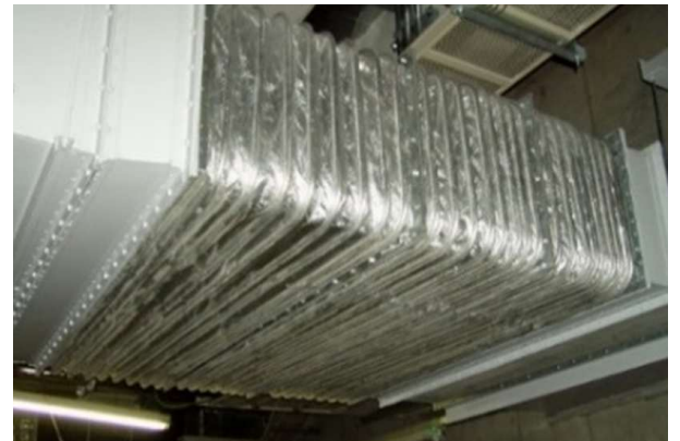
排煙用 耐熱280℃仕様 免震量500 口径1980/580□×取付長1600L (本体はガラスクロス等の複合材)
